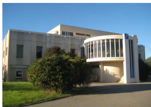
Direction Départementale des Équipements, Trébon
