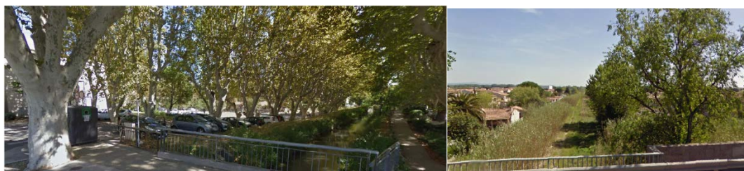
Canal de Craponne et voie ferrée de Trinquetaille
