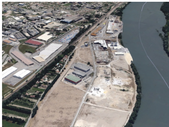
La plateforme portuaire d'Arles nord
